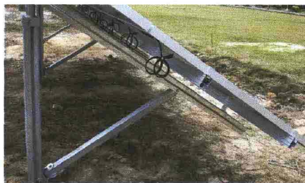
Il sistema «EZ-Rack Solarterrace II» di Clenergy ha una struttura semplice ed è dotato di profilati di sezione relativamente ridotti.
